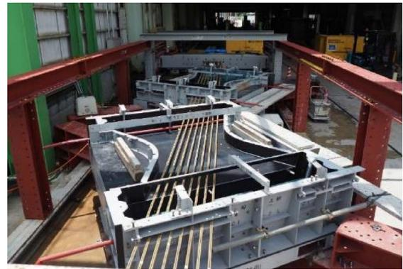
Fig. 6 Butterfly web fabrication
