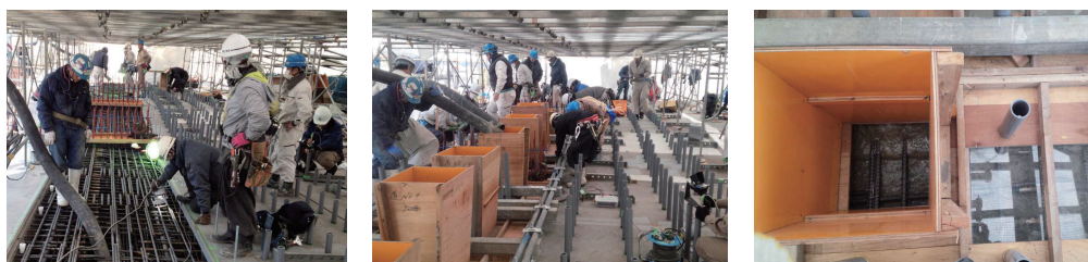
a) 底版への打込み b) 上床版への打込み c) 充填確認
