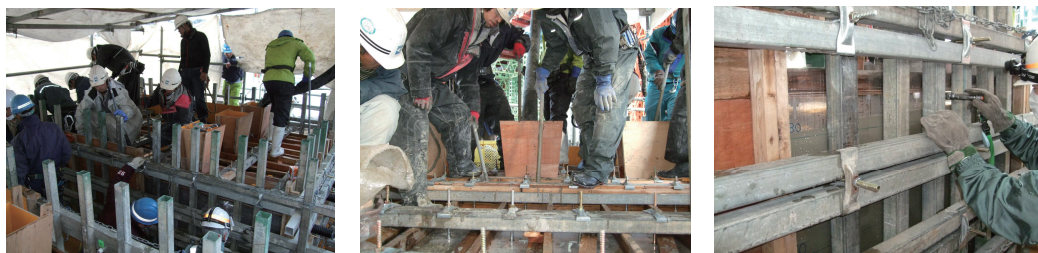
a) 打設口からの打込み b) 充填補助作業 c) 充填確認
