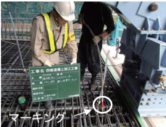
写真-1 挿入深さマーキング
