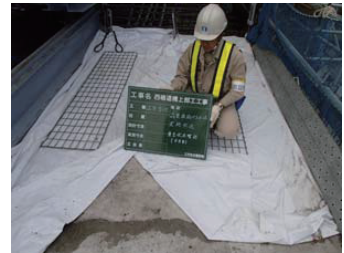
写真-3 養生状況
