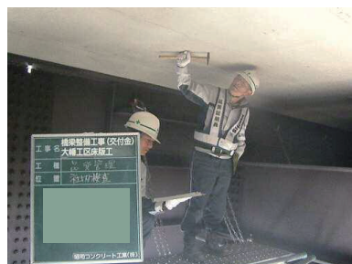
写真-4 初期点検状況
