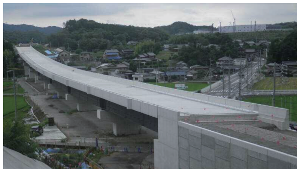
写真-5 工事完了全景 (A2側より望む)
