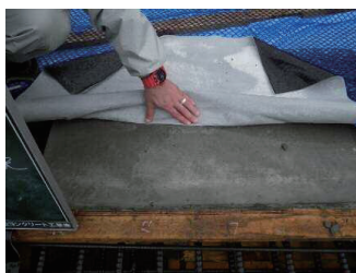
写真-2 養生マット
