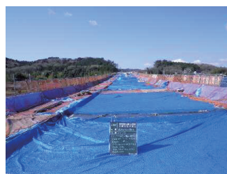
写真-3 養生全景
