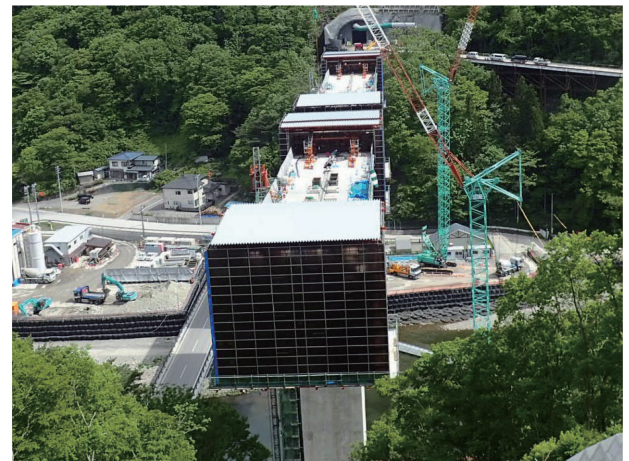
写真 - 4 移動作業車の屋根
