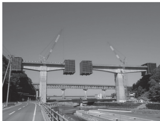
写真 - 1 張出し架設状況
