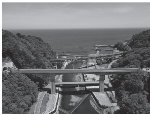
写真 - 10 完了後全景（上流側より）
