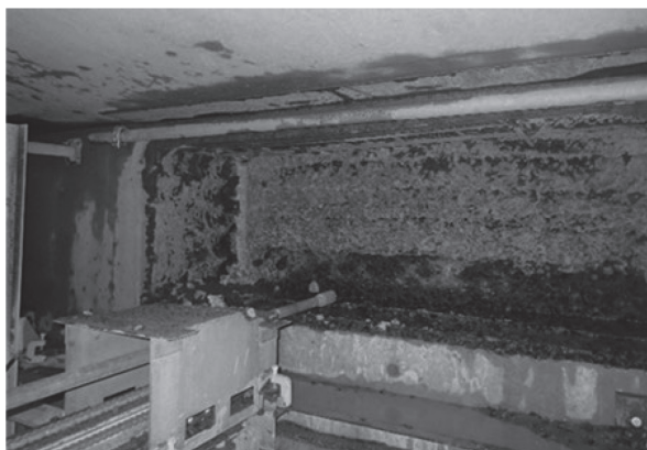
写真 - 8 ウォータージェット工法
