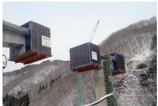
写真 - 3 採光パネルを使用した移動作業車
