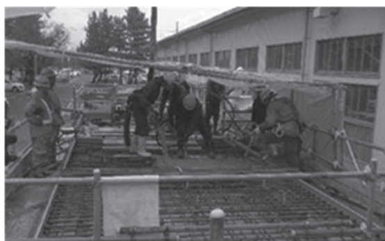
写真 - 3 施工性確認試験の打込み状況 13)
