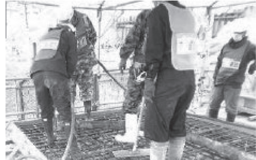
写真 - 4 試験施工の打込み状況
