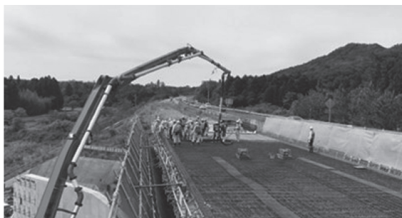
写真 - 5 本施工での打込み状況 13)
