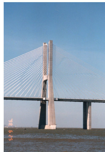
写真 - 8 2面吊りのセミファン形の斜材と主塔
