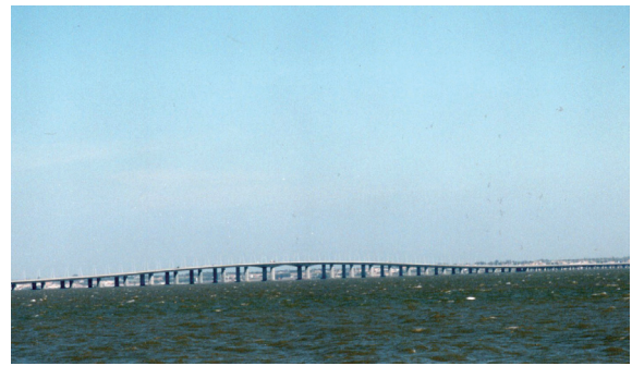
写真 - 6 中央高架橋
