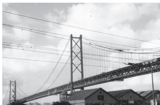
写真-5 改修工事中の4月25日橋
