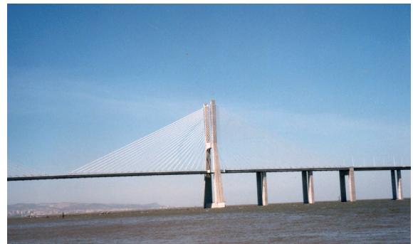
写真 - 7 中央高架橋側の中央斜張橋の主塔と斜材
