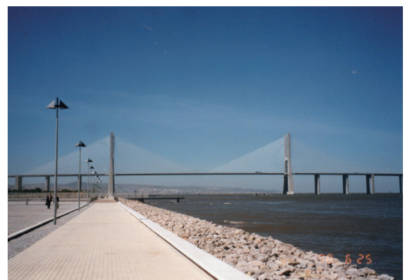
写真 - 9 リスボン国際博覧会会場からの中央斜張橋
