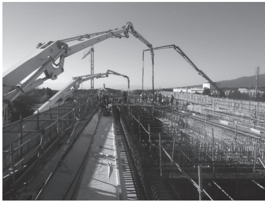
写真 - 3 コンクリート打込み状況
