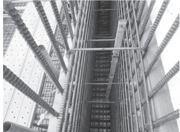
写真 - 6 コンクリートの打上げ高さ表示
