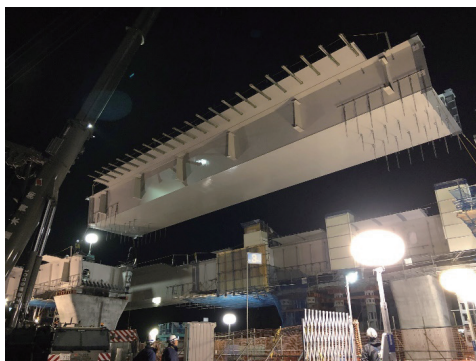
写真 - 10 鋼桁架設状況（夜間一括架設）
