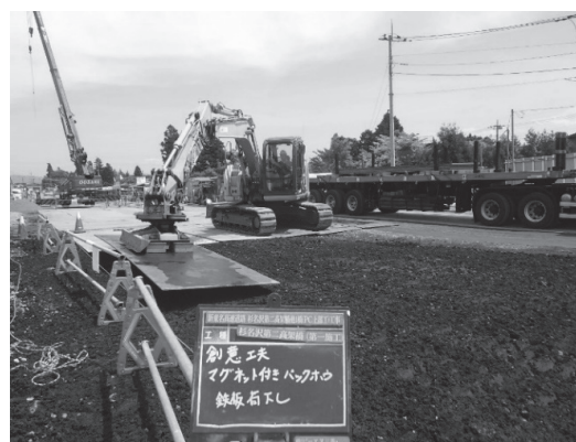
写真 - 2 マグネット式バックホウの敷鉄板設置状況
