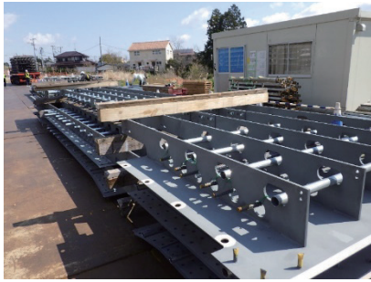
写真 - 9 合成床版パネル
