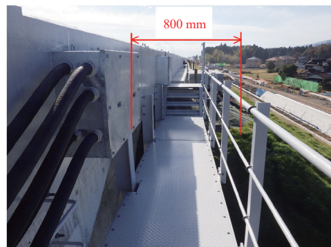
写真 - 12 検査路写真
