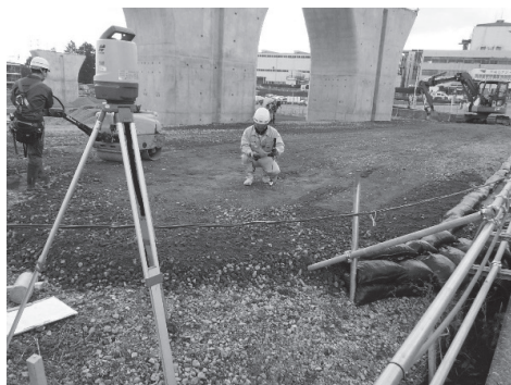
写真 - 15 支保工一人測量
