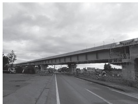
写真 - 16 混合橋完成写真
