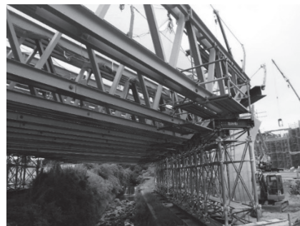
写真 - 1 特殊支保工設置状況
