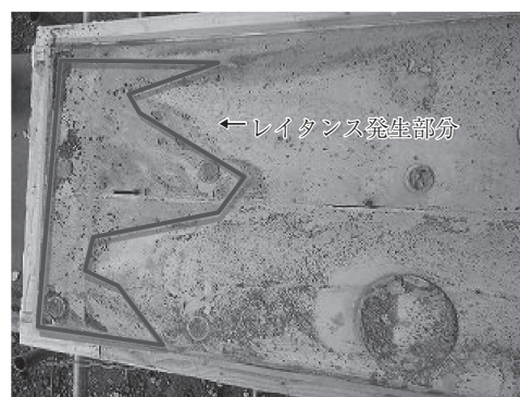
写真-7 鋼殻セル天端部状況
