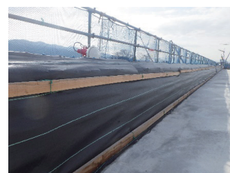
写真 - 13 遮光シートによる壁高欄鉄筋の養生
