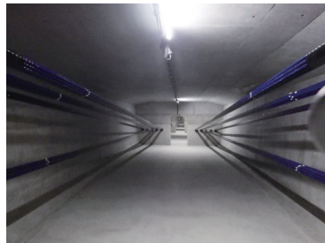
写真 - 11 桁内照明設置状況
