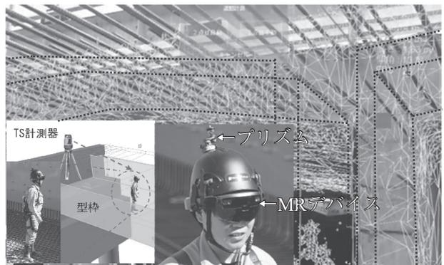
写真 - 3 MR 技術を用いた型枠・出来形検査状況
