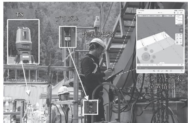
写真 - 1 座標管理システム試行状況
