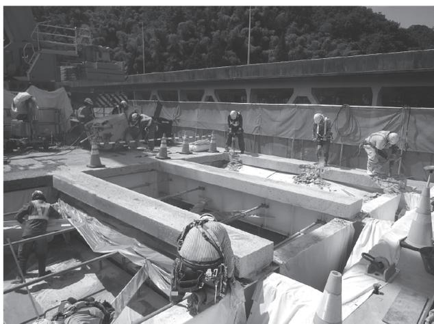
写真 - 6 ハンドブレーカーによる既設床版撤去状況
