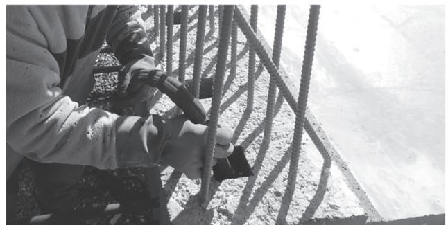
写真 - 1 プレテンション PC 鋼材のプラズマ切断状況
