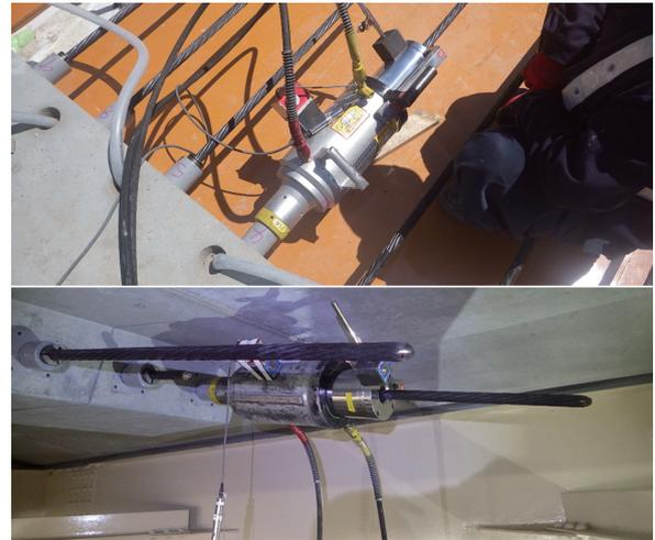
写真 - 9 縦締め PC 鋼材緊張状況
