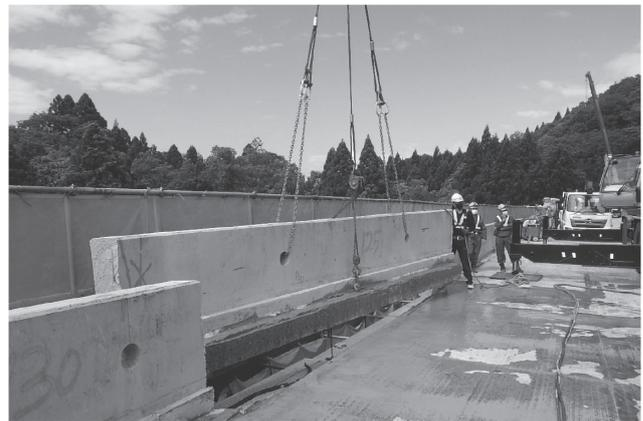
写真 - 4 既設壁高欄撤去状況
