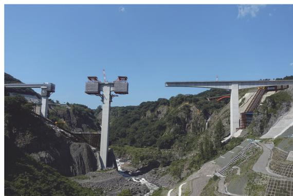
写真 - 3 PR2 側の張出し施工状況 (2020 年 6 月撮影)
