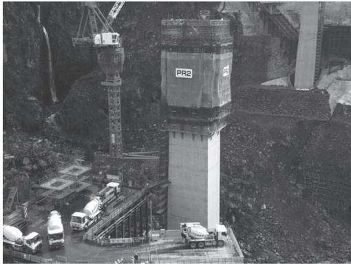
写真 - 2 ACS による橋脚の施工状況
