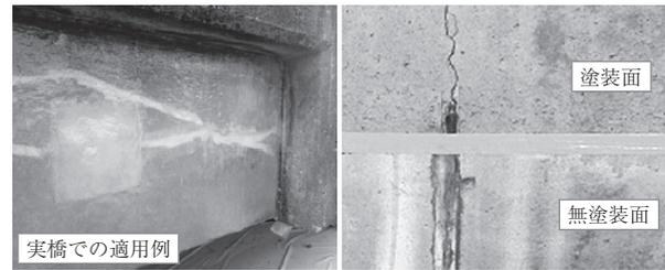
図-3 コンクリート面を視認できる透明な表面被覆の例
