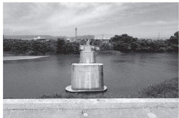
写真 - 14 ゲルバー桁撤去完了
