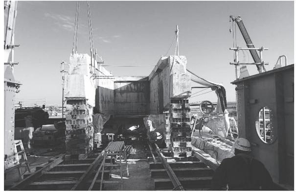
写真 - 7 撤去桁 2 次切断状況
