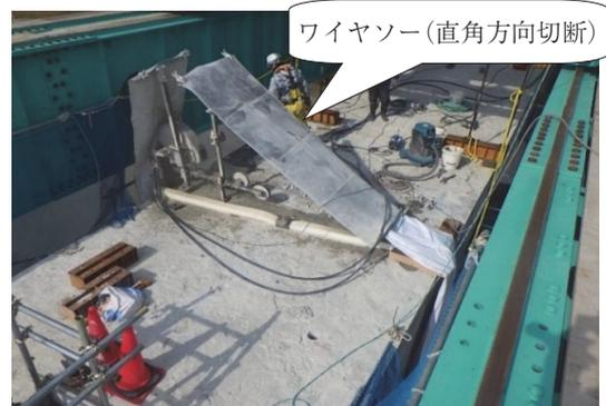
写真-5 撤去桁のワイヤソー切断
