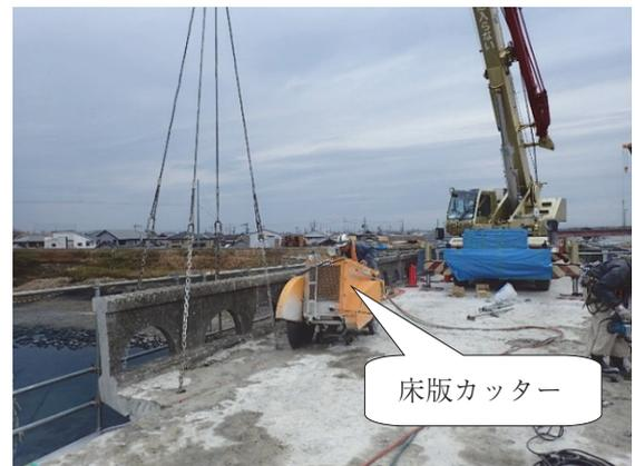
写真-4 高欄・張出床版切断状況
