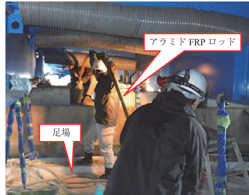
写真 - 10 全展開したアラミド FRP ロッド
