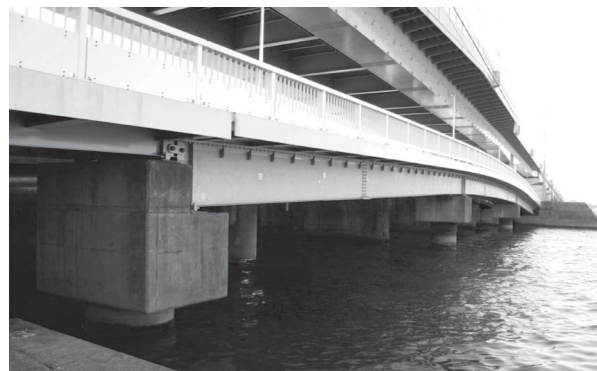
写真 - 17 補強完了全景
