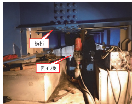
写真 - 11 削 孔
