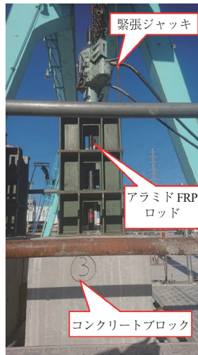
写真 - 9 引張試験状況
