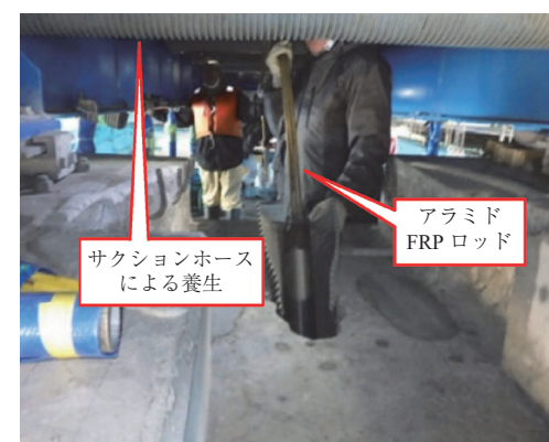
写真 - 13 アラミド FRP ロッド挿入
