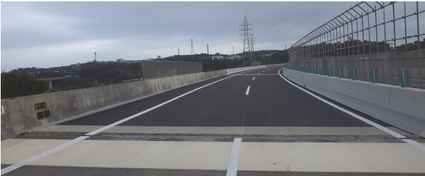
写真 - 7 億首川橋 対面工事完了
