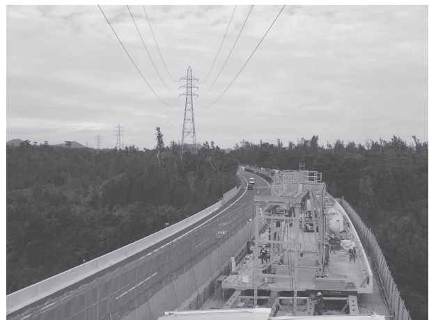
写真-2 高圧送電線と門型床版取替え機の関係
