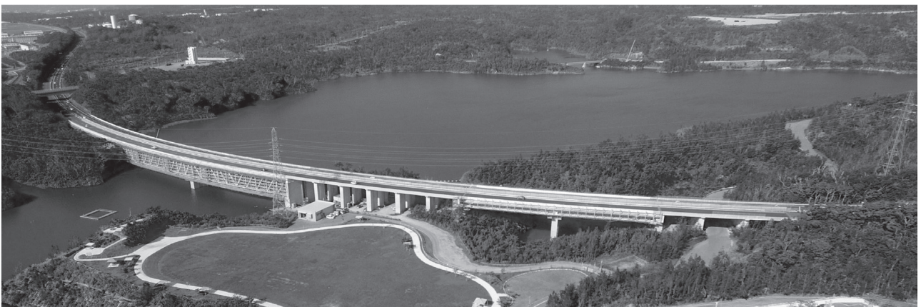
写真 - 14 億首川橋 施工完了（全景）
