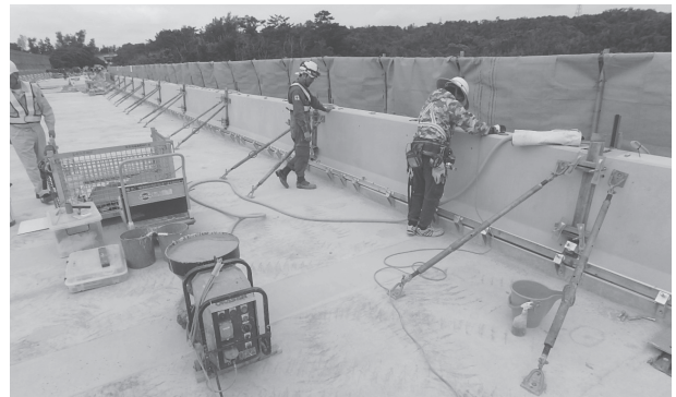
写真 - 12 モルタル注入状況
