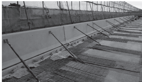
写真 - 10 転倒防止対策・架設完了
