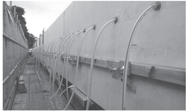
写真 - 11 型枠組立て・ホース設置状況
