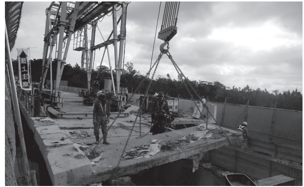
写真 - 3 撤去状況
