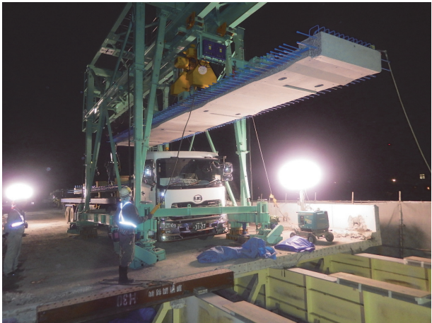
写真 - 5 架設状況
