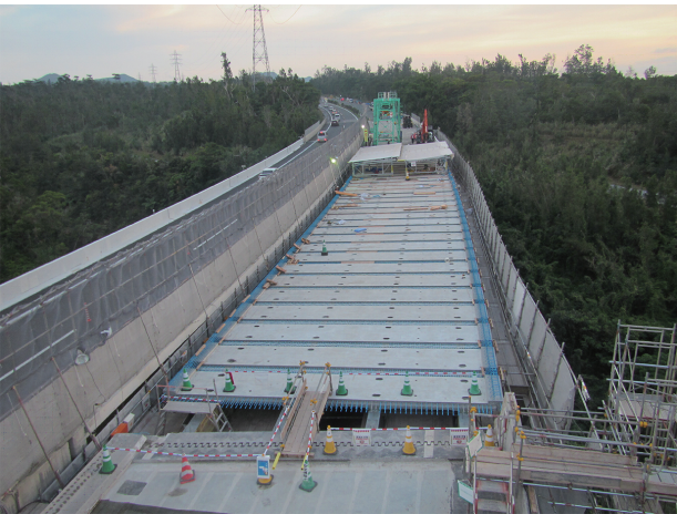
写真 - 6 架設完了
