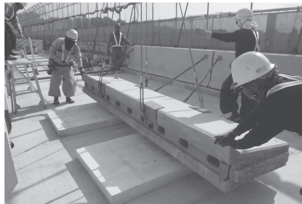
写真 - 8 壁高欄荷卸し状況
