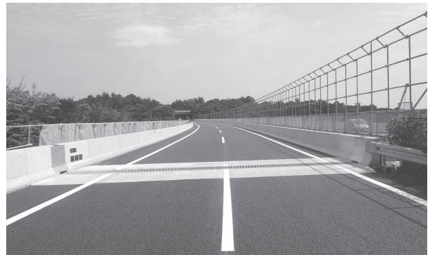
写真 - 13 福地川橋 対面工事完了
