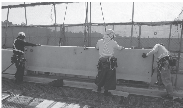
写真 - 9 壁高欄架設状況
