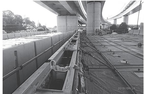
写真 - 3 PCa 壁高欄（現場ヤード）製作状況
