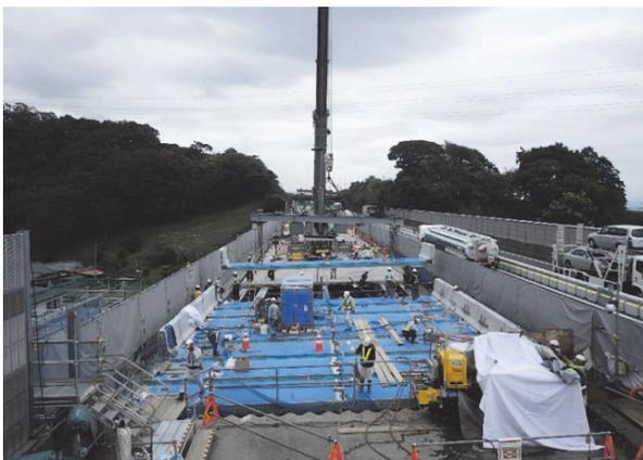
写真-6 200tクレーンによる架設状況
