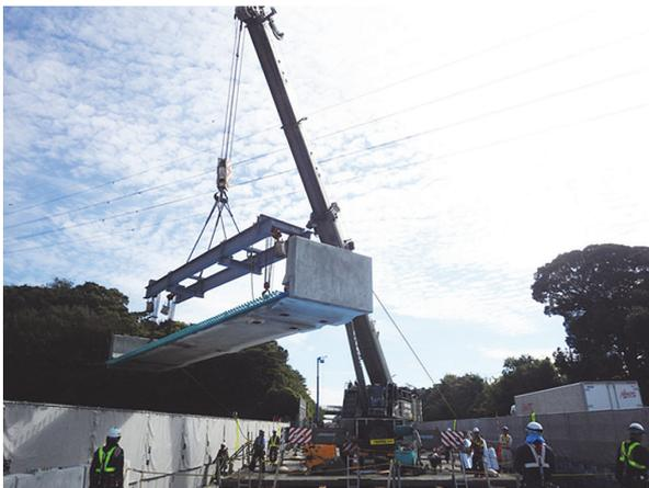
写真-7 高圧線位置の架設状況
