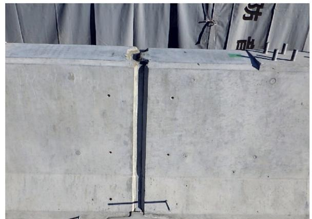
写真-9 PCa壁高欄目地部
