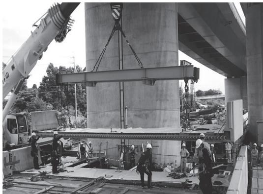
写真 - 4 施工性確認試験状況（架設試験）
