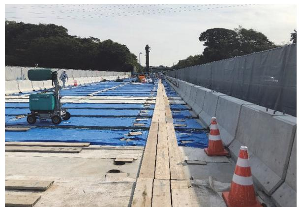
写真-10 PCa壁高欄施工後橋面状況写真
