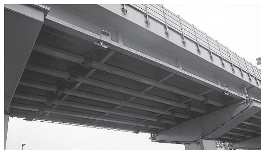
写真 - 3 主桁補強工（外ケーブル補強）
