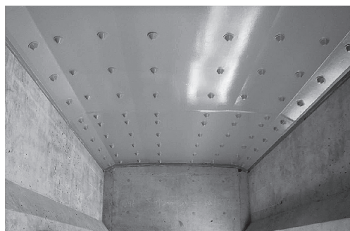
写真 - 4 床版部補強工（鋼板接着補強）
