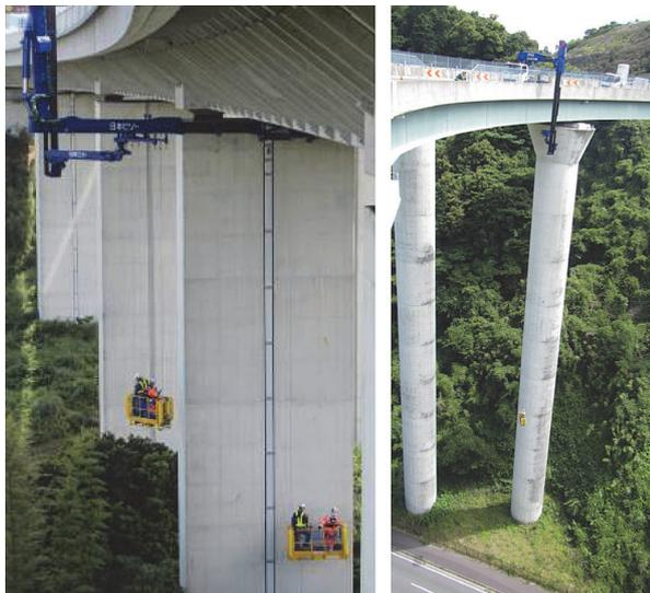
写真 - 2 ゴンドラ車による点検状況
