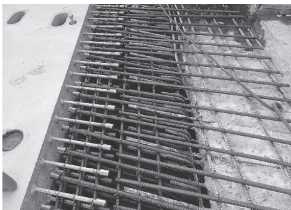
写真 - 9 1期施工完了時の鉄筋配置状況
