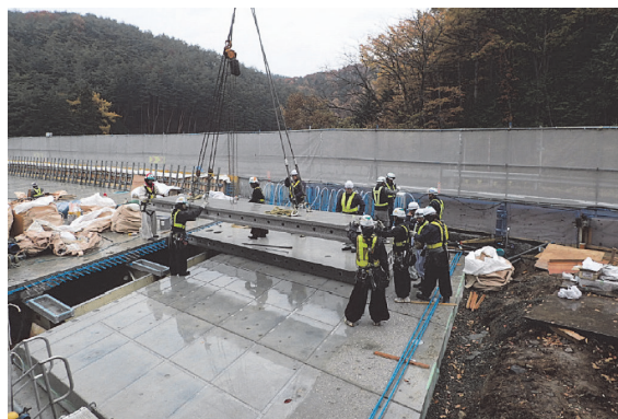
写真 - 7 延長床版の設置状況
