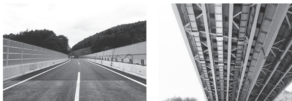
写真-12 接合部の完成状況
