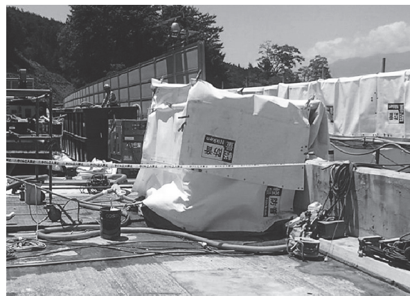
写真 - 11 WJはつり時の騒音抑制対策の状況
