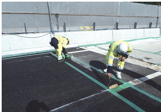
写真 - 8 舗装表面強化材の塗布状況
