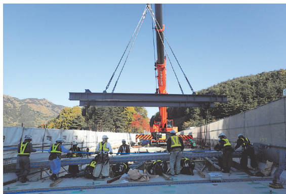
写真 - 6 SLJ スラブの架設
