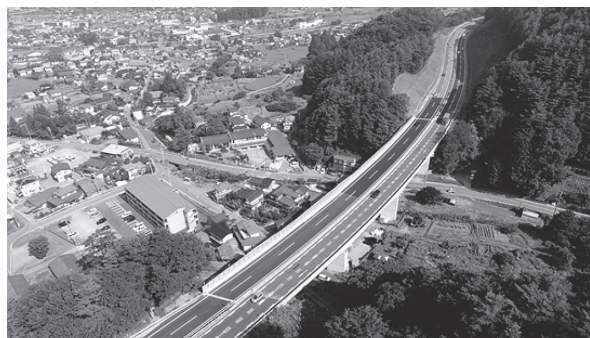
写真-13 工事完成状況
