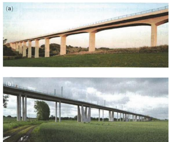
図 - 6 ドイツの上下部一体構造橋梁: (a) Scherkondetal 高架橋, (b) Gänsebachtal 高架橋 (写真: Steffen Marx)
