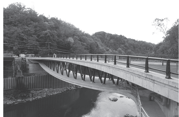
写真 - 8 白虹橋（右岸上流側より）
