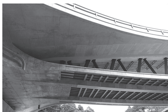
写真 - 12 角形鋼管と一次ケーブルの配置
