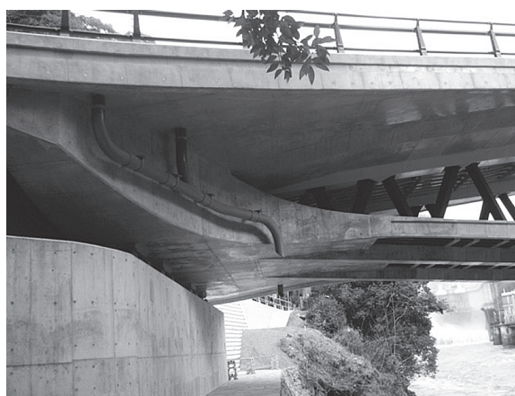
写真 - 13 端部拡幅部の3次元曲面
