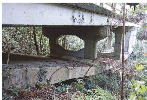
写真 - 3 速日峰橋の側部の床版と鉛直材
