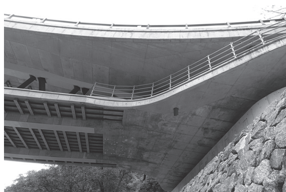
写真 - 11 右岸支承部
