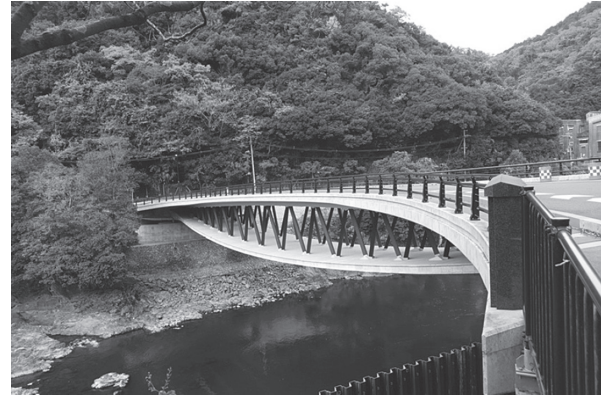
写真 - 7 白虹橋（左岸下流側より）
