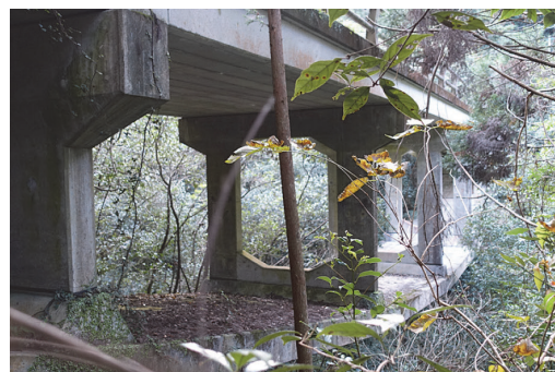
写真 - 2 速日峰橋の中央部の床版と鉛直材
