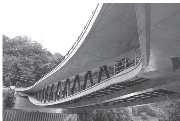
写真 - 10 右岸上流側からの白虹橋
