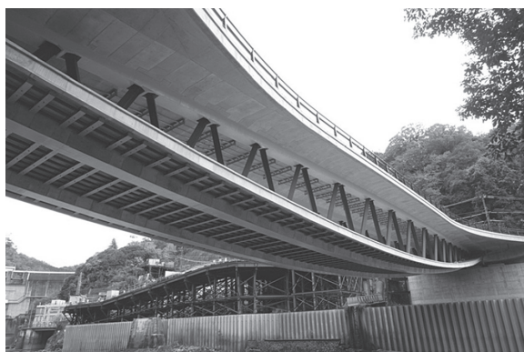
写真 - 9 右岸下流側からの白虹橋
