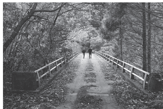
写真 - 5 速日峰橋の橋面
