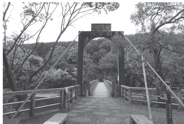
写真 - 14 下流の天ヶ瀬吊橋
