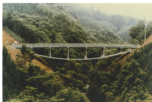
写真 - 1 竣工時の速日峰橋 (出典：(株) ピーエス三菱)
