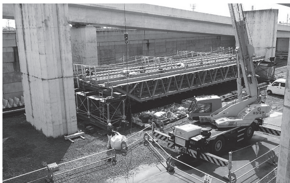
写真 - 9 トラス梁仮置き状況
