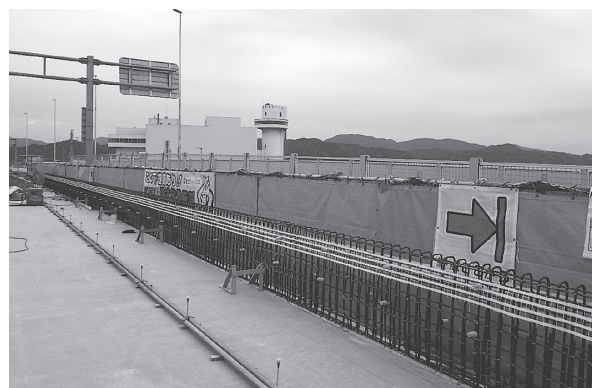
写真 - 12 地覆工施工時安全垂れ幕設置状況
