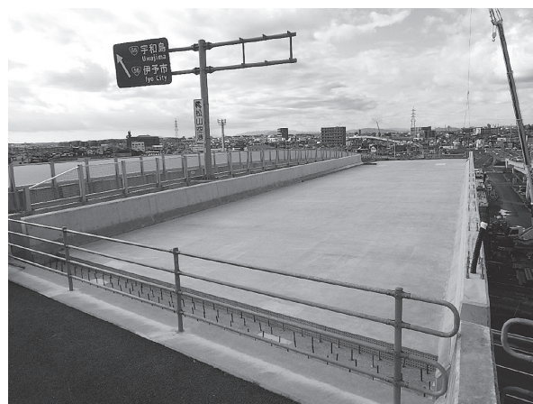
写真 - 14 完成写真（終点側より）
