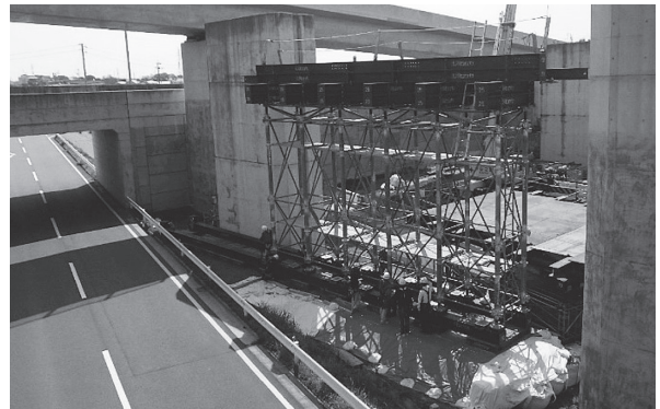
写真 - 8 支保工横移動・据付け状況
