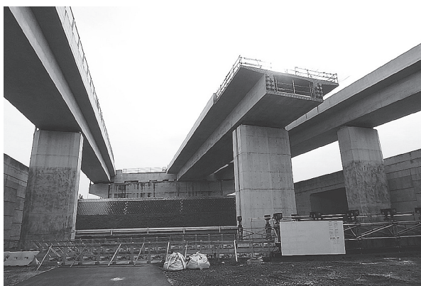
写真 - 13 完成写真（起点側より）
