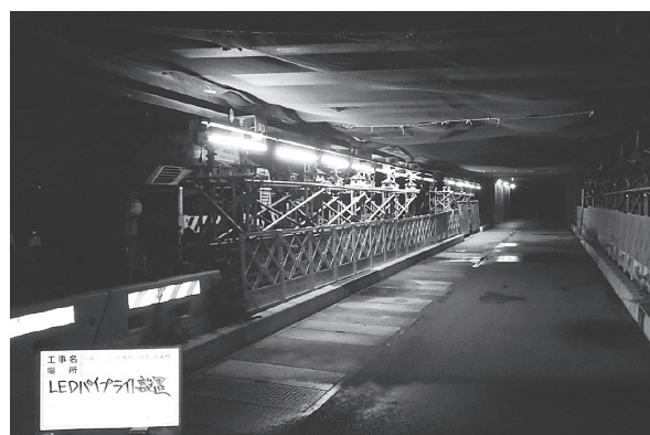
写真 - 4 遊歩道へのLEDライト設置状況
