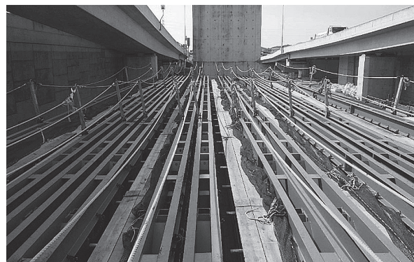
写真 - 10 トラス梁足場組立て状況
