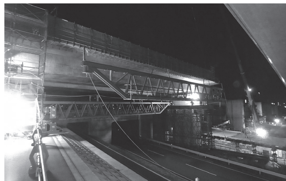
写真 - 2 トラス梁夜間撤去状況
