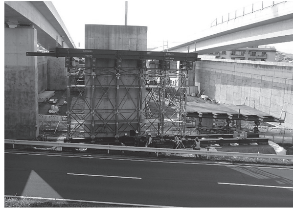
写真 - 7 支保工組立て状況
