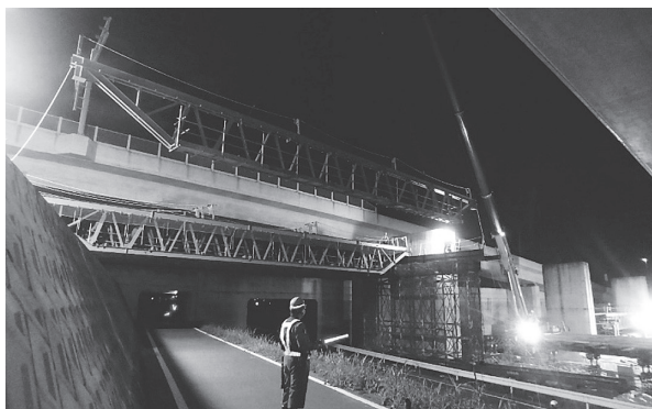
写真 - 1 トラス梁夜間架設状況
