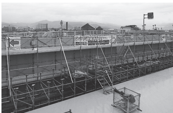
写真 - 11 PC箱桁製作工時安全垂れ幕設置状況
