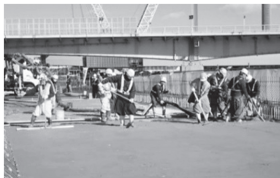
写真 - 9 床版打設状況
