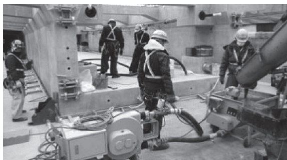
写真 - 7 底版モルタル充填状況
