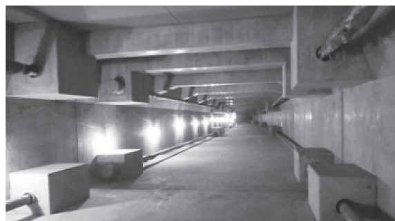
写真 - 10 ボックスカルバート完成時
