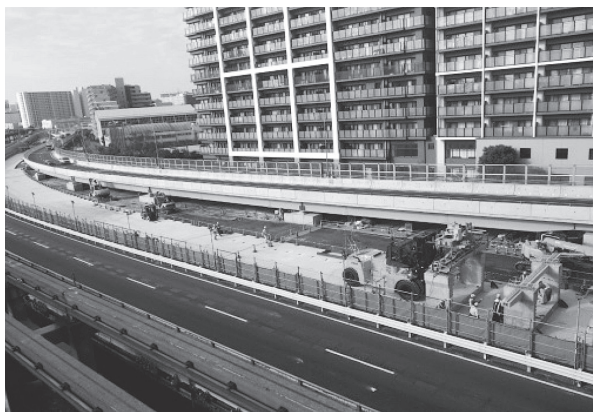
写真 - 3 セグメント架設全景
