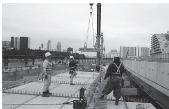
写真 - 8 PC 板敷設状況
