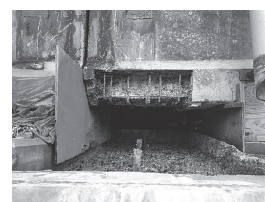
既設支承撤去
