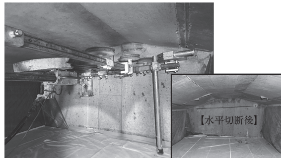
図 - 12 中間横桁の先行切断状況
