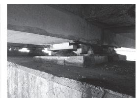
支承取替え前
