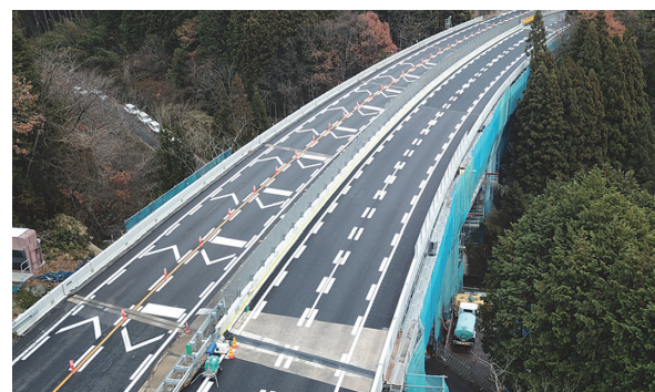
下り線完了（全景）
