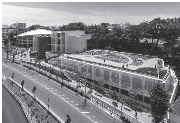
写真 - 6 階高を抑えたプールの外観
