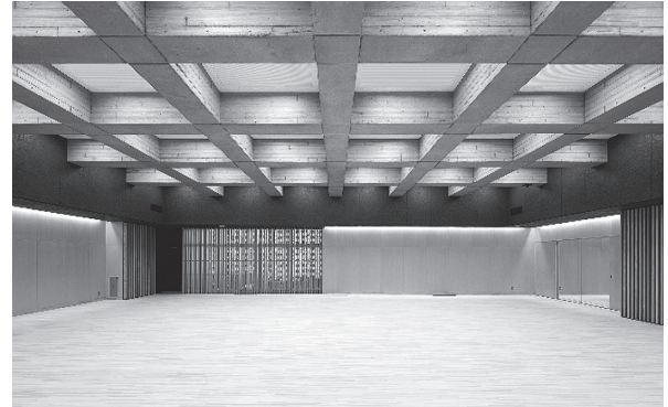
写真-5 武道場の格子梁
