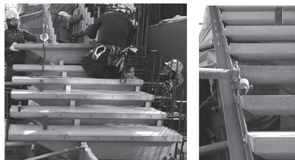
(a) PCaPC 階段設置状況 (b) 固定アングル
