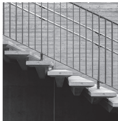
写真 - 15 PCaPC 階段施工状況
