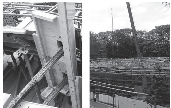
写真 - 12 通線状況
