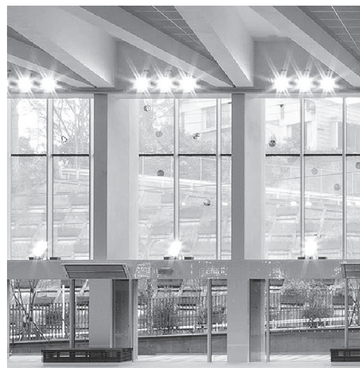
写真 - 7 扁平六角柱とプレストレストクロス梁の内観
