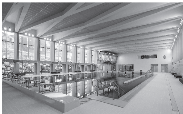
写真 - 3 地下階で自然採光・自然通風を確保したプール
