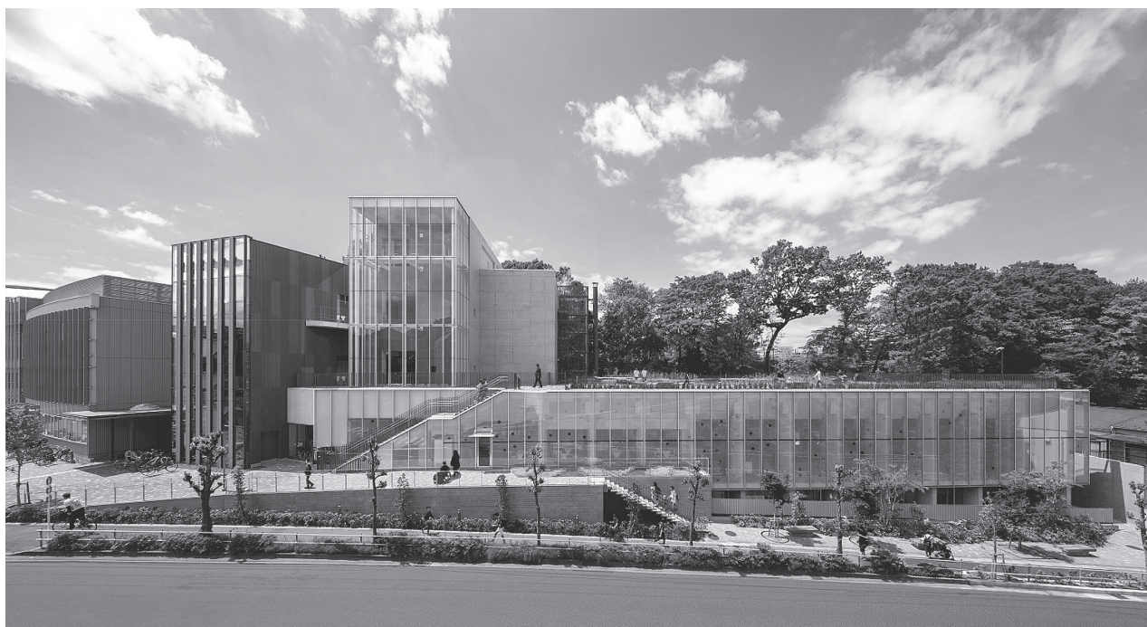
写真 - 2 背面の公園から連続する緑と傾斜地に水平・垂直に伸びる軽やかなファサード
