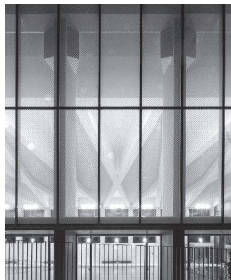
写真 - 8 扁平六角柱とプレストレストクロス梁の外観
