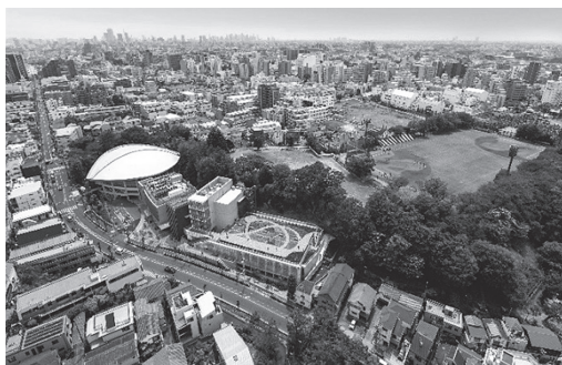
写真 - 1 公園内施設と連続するプール棟
