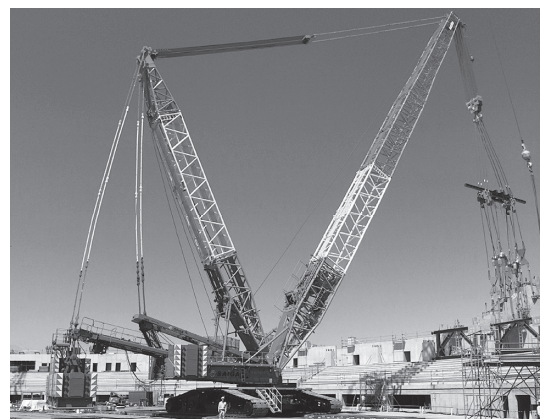
写真 - 13 建方揚重機（750 t クローラークレーン）
