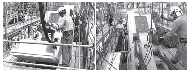
(a) PC 鋼より線挿入 (b) PC 鋼より線緊張
