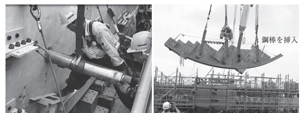
(a) 吊上げ治具（鋼棒）挿入状況 (b) 段梁揚重状況
