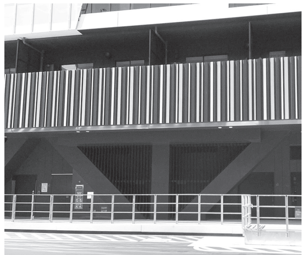
写真 - 11 1階PCトラス梁外観②
