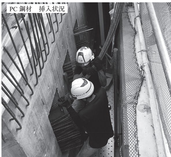
写真 - 2 PC鋼材挿入工事
