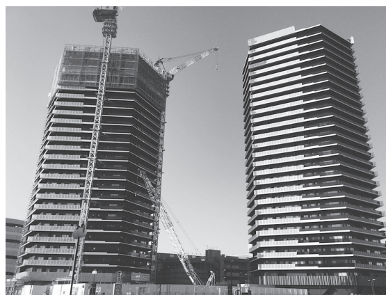
写真 - 1 建物全景写真
