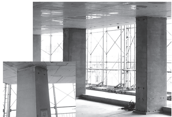
写真 - 6 上部PCa柱・フラットスラブ
