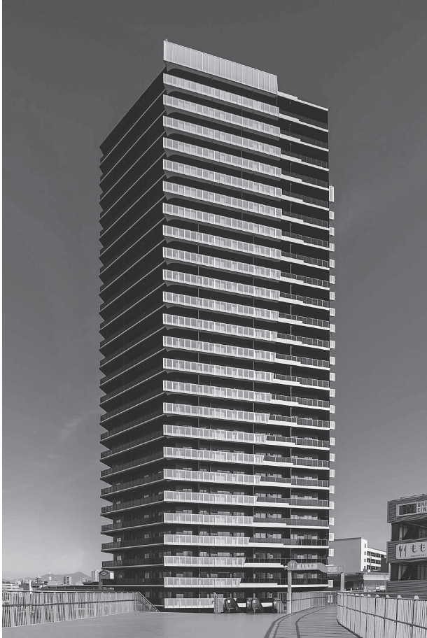
写真 - 8 建物全景
