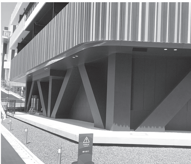
写真 - 10 1階PCトラス梁外観①
