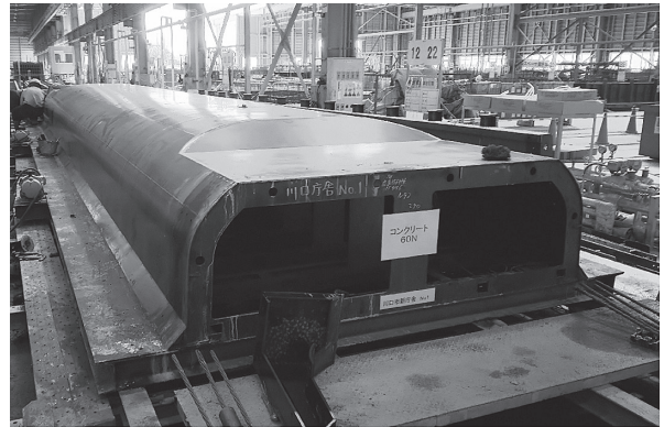
写真 - 7 型枠の状況 (PS1)
