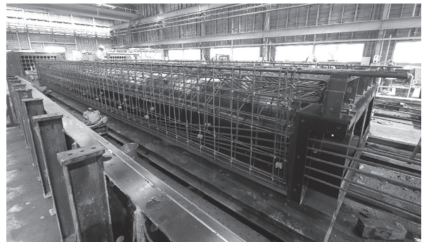
写真 - 8 配筋状況
