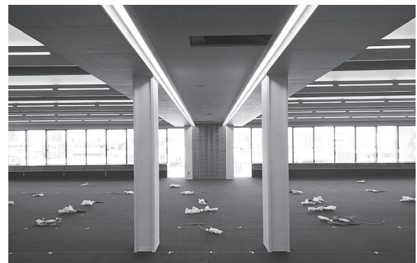
写真 - 2 見え掛りとなる 300 × 400 mm の柱
