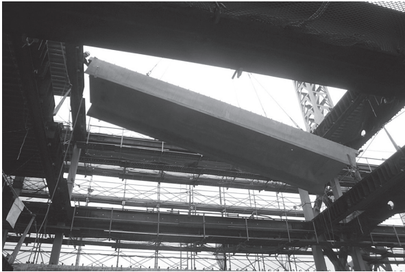
写真-10 PC床版の架設状況
