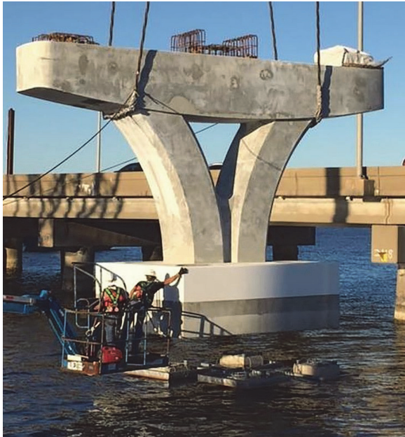
図 - 4 下部構造ユニット施工状況
