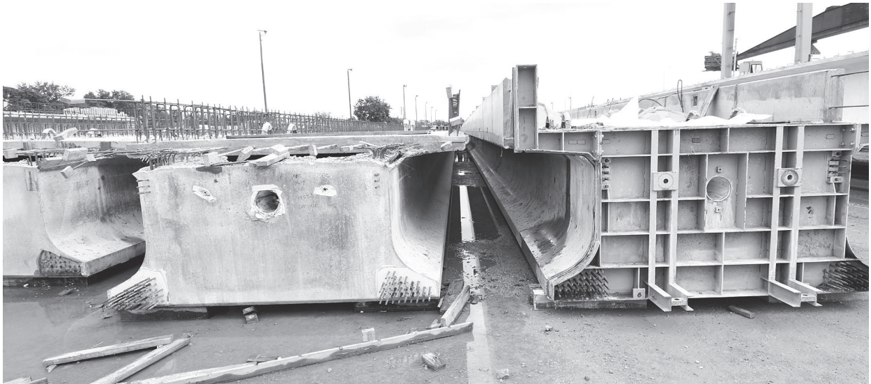
図 - 7 π 型形状の標準桁の仮置き状況
