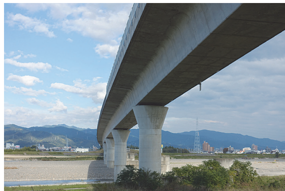
写真 - 3 重信高架橋の河川部の橋脚
