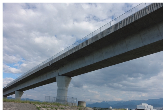
写真 - 1 重信高架橋
