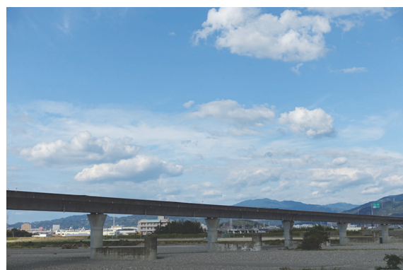
写真 - 2 重信高架橋の河川部
