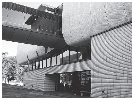
写真-13 多種の曲面をブリッジで連結させたジョイント
