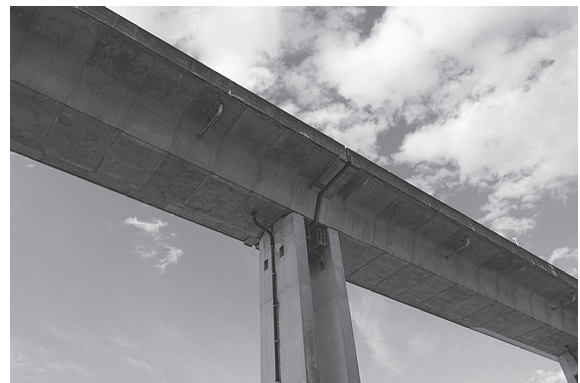
写真 - 7 端部の二枚壁式橋脚
