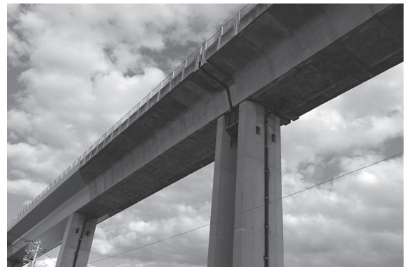
写真 - 6 陸上部のラーメン構造の端部橋脚
