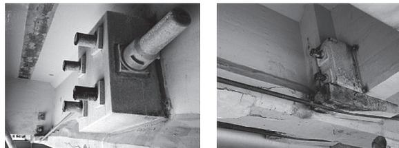
写真 - 2 外ケーブル補強状況（2016 年撮影）
