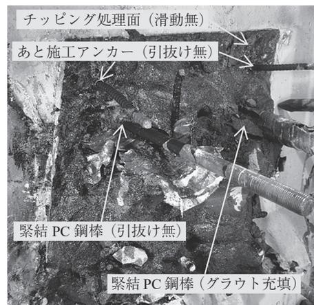
写真 - 11 定着装置と既設桁の接合部の状況
