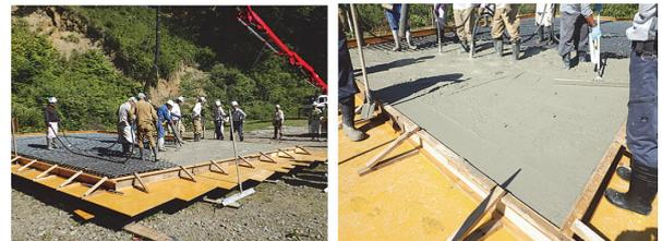
写真 - 3 コンクリート打込み状況
