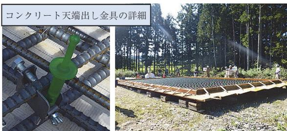
写真 - 2 コンクリート天端出し金具の配置状況
