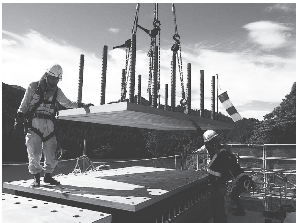
写真 - 4 ゴム支承設置状況
