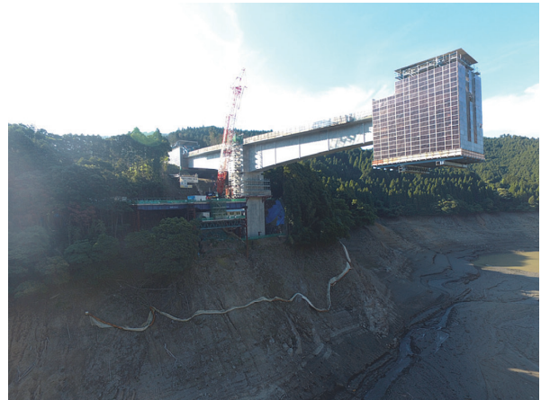
写真 - 3 超大型ワーゲンによる施工
