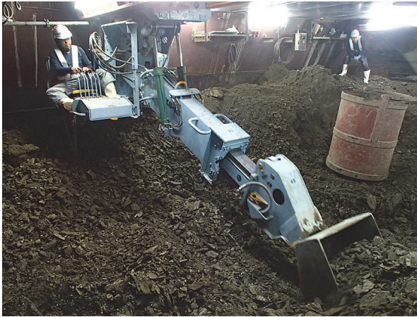
写真 - 1 函内ショベルによるケーソン掘削状況
