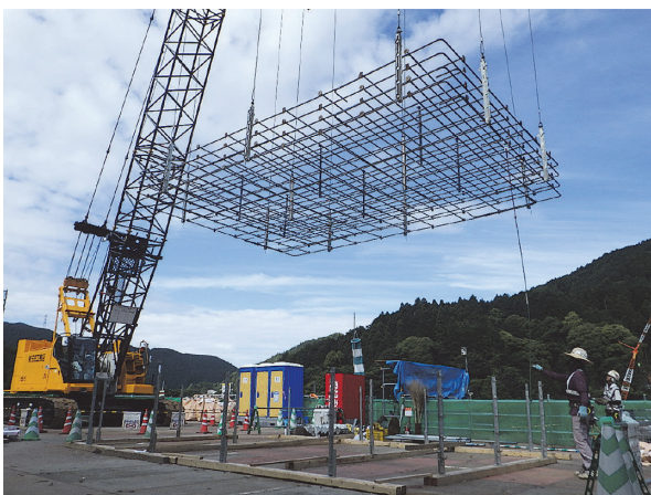
写真 - 2 鉄筋のプレファブ化
