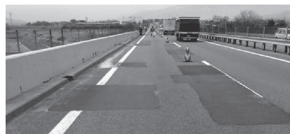
写真 - 3 舗装路面のポットホール補修状況
