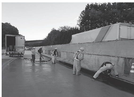
写真 - 6 高性能床版防水工の施工状況
