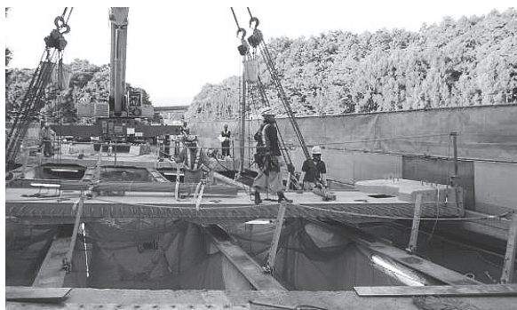
写真 - 4 プレキャスト PC 床版の取替え工事
