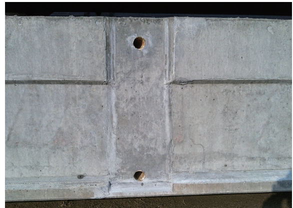
図 - 13 横締めPC鋼材位置のせん断キー
