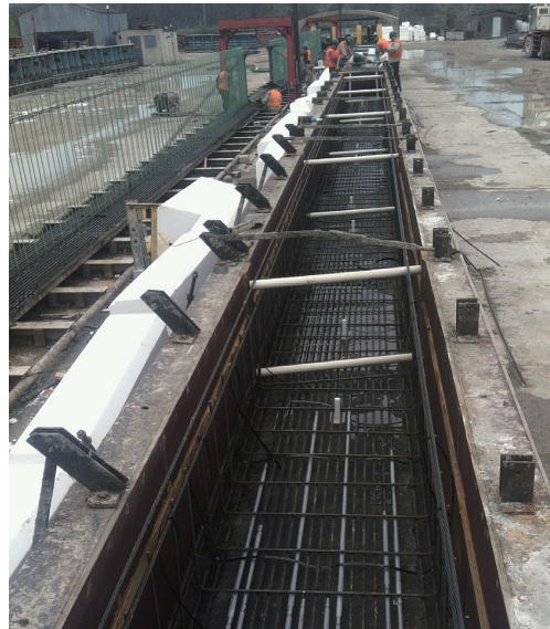
図 - 12 コンクリート打設前の主桁の鉄筋配置状況
