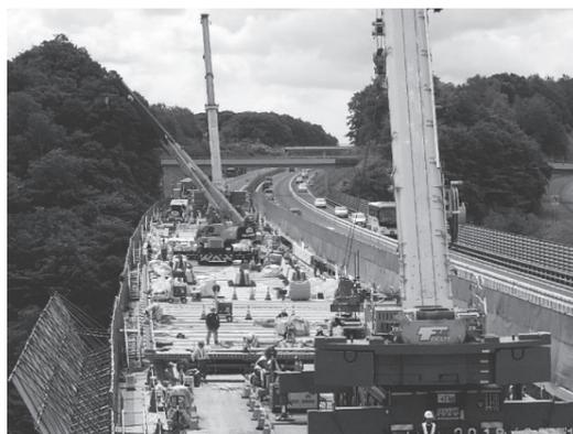
写真 - 6 架設クレーン配置状況
