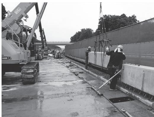
写真 - 8 プレキャスト壁高欄設置状況
