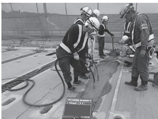
写真 - 9 間詰めコンクリート締固め状況
