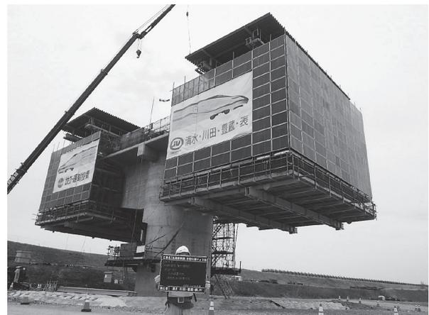
写真 - 3 全天候型移動式作業車
