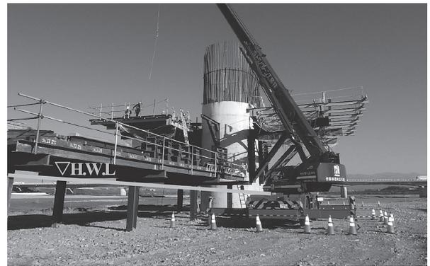
写真 - 1 ブラケット支保工および仮設構台
