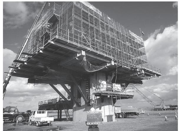
写真 - 2 移動作業車作業床の先行設置
