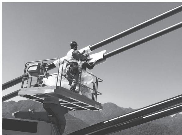
写真-6 斜ケーブル火災対策工の施工
