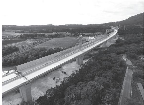
写真 - 1 PRC 3 径間連続エクストラードズド橋全景
