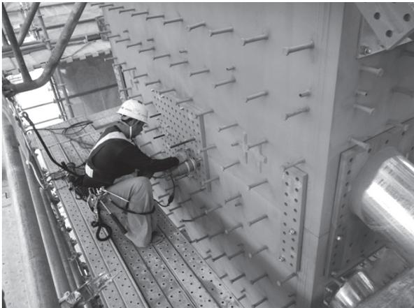
写真-7 鋼殻表面に設置された巻立てコンクリート接合用のスタッド
