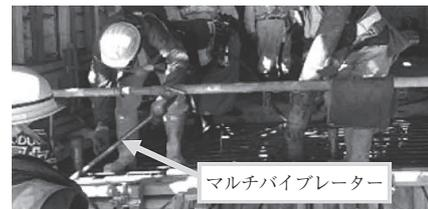
写真 - 2 マルチバイブレーター使用状況
