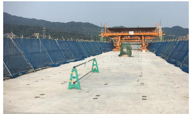
写真 - 6 橋面上飛散防止設備
