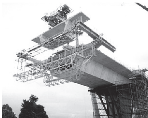
写真-4 エレクションノーズ架設 2)
