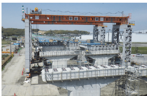
写真 - 1 自走式門形クレーン架設
