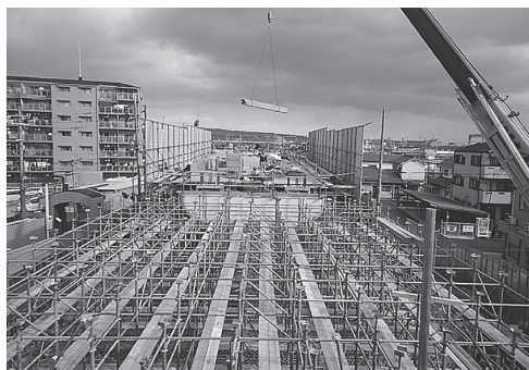
写真 - 5 くさび結合式支保工 5) の組立状況
