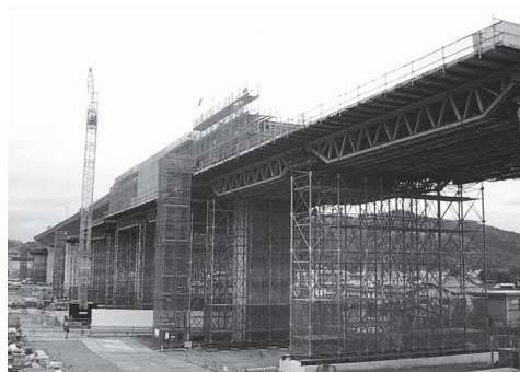
写真 - 7 トラス材を用いた支柱式支保工
