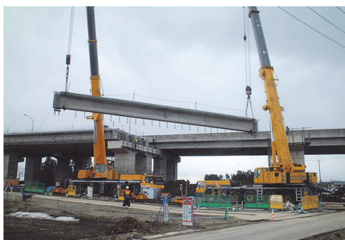
写真 - 2 トラッククレーン架設
