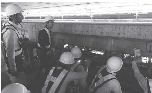
写真-4 既設下り線の床版切断面
