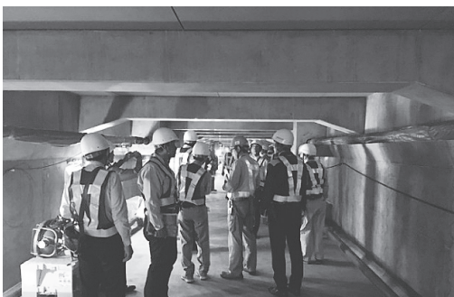
写真-2 PCaPC ボックスカルパート内の状況
