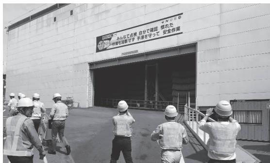
写真 - 5 セグメントストックヤード建屋
