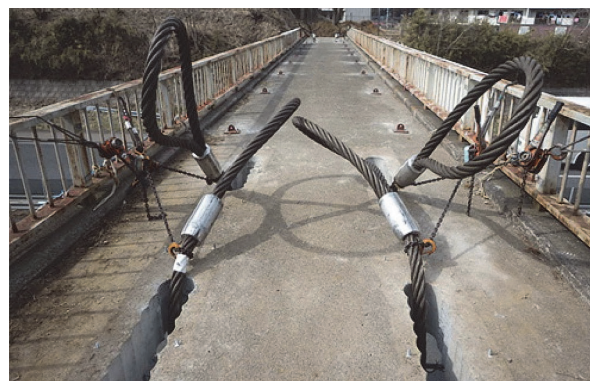
写真-1 吊孔削孔とワイヤリング状況
