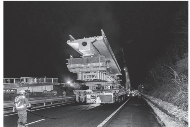
写真 - 4 中央径間の橋体の運搬状況
