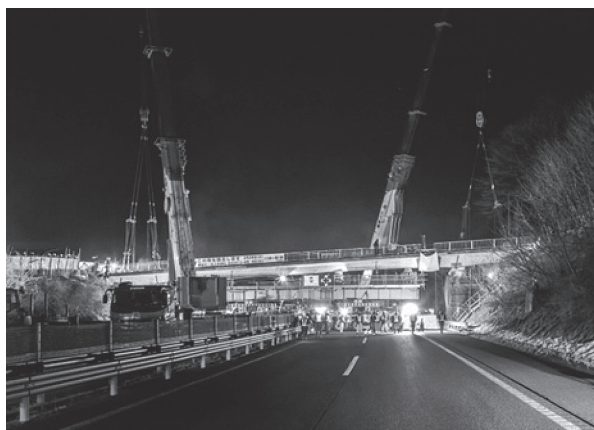
写真 - 6 溝上橋撤去状況
