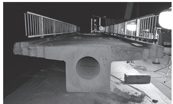
写真 - 5 ワイヤソーによる橋体切断面
