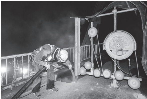
写真 - 3 乾式ワイヤソーによる切断状況
