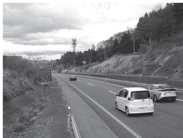
写真 - 8 溝上橋撤去後の高速道路の状況
