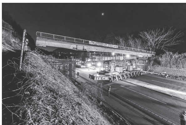
写真 - 7 月夜の平橋撤去状況
