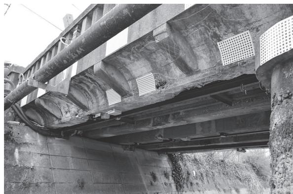
写真 - 2 センサーの設置状況
