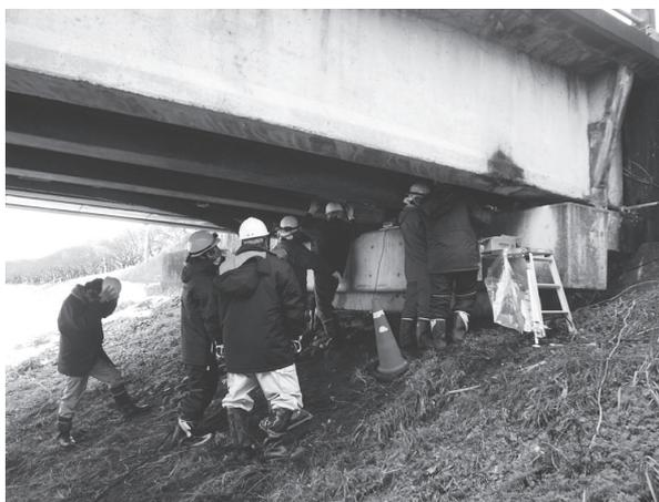
写真 - 5 シート型センサーの設置状況
