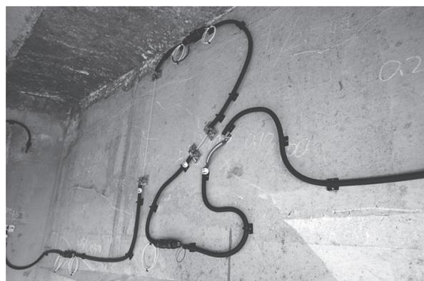
写真 - 3 光ファイバーの設置状況
