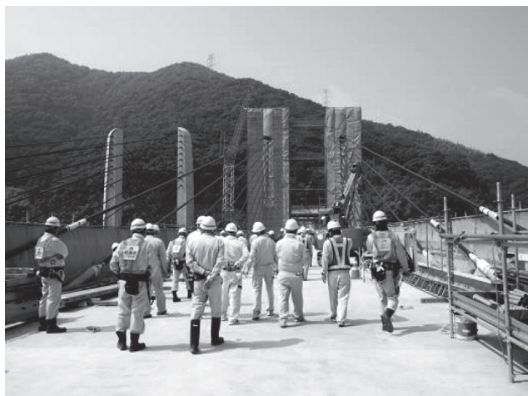
写真-3 長崎自動車道「日見夢大橋」見学会
