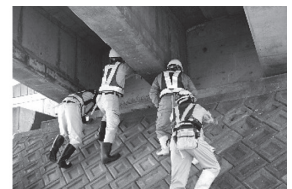
写真-2 橋梁点検実習 1)
