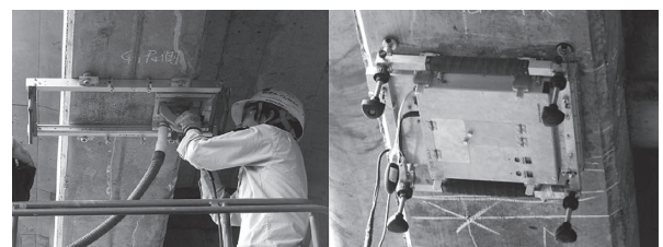
写真-4 スリット切削と画像撮影状況 5)
