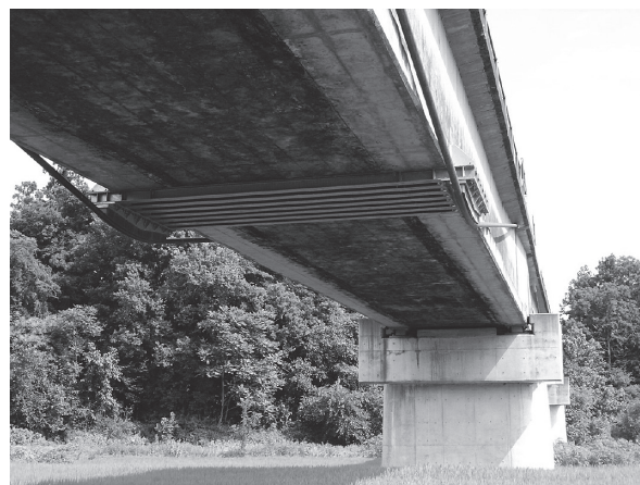
図 - 7 外ケーブル補強後の小坂子第一水路橋の床版下面
