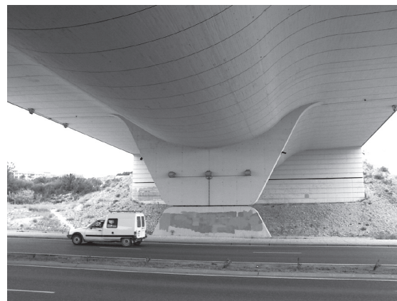
写真 - 9 断面が逆アーチ状のシェル構造の 3 径間連続桁 PC 水路橋 3)
