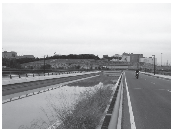
写真 - 8 PC 水路橋の上面 3)
