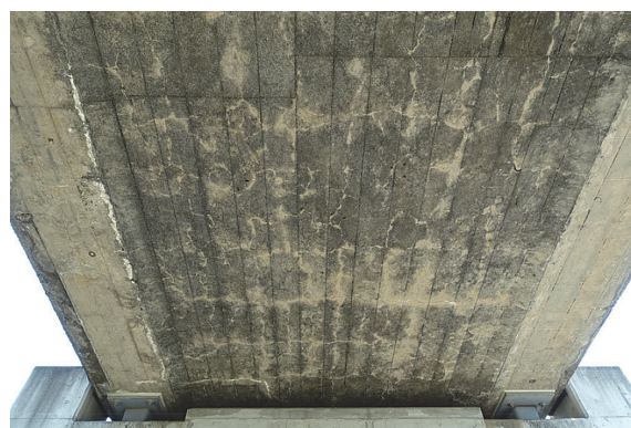
写真 - 5 外ケーブル補強後の細ヶ沢水路橋の床版下面
