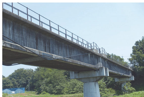
写真 - 3 外ケーブル補強後の細ヶ沢水路橋
