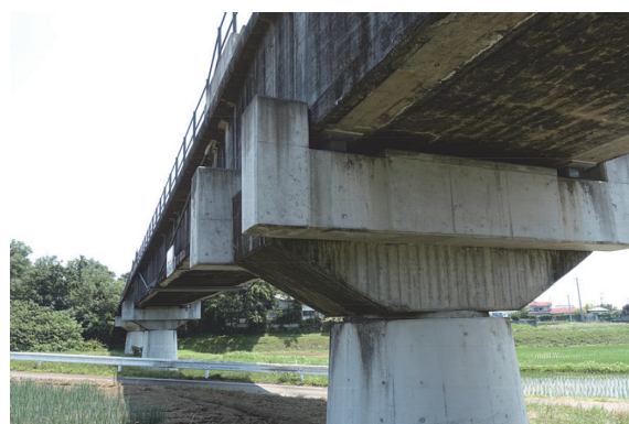
写真 - 4 外ケーブルと耐震補強後の細ヶ沢水路橋
