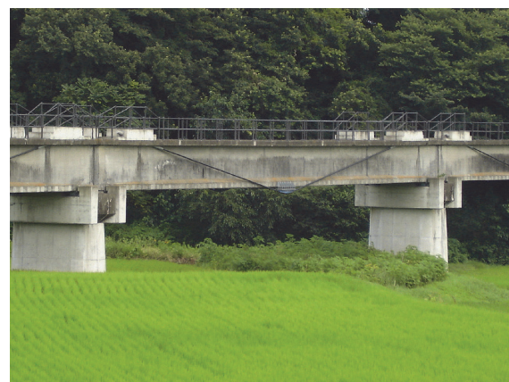
写真 - 6 外ケーブル補強後の小坂子第一水路橋
