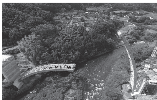
写真 - 6 3次ロアリング状況
