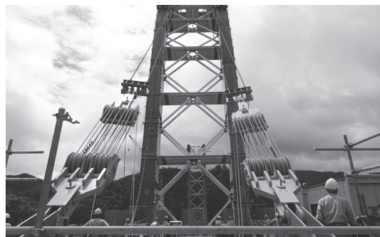
写真 - 4 2次ロアリング状況
