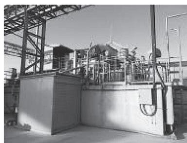
写真 - 15 濁水処理装置
