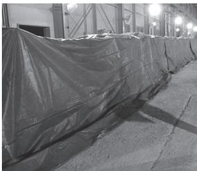
写真 - 6 蒸気養生状況
