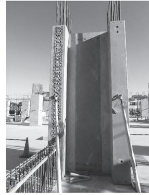
写真 - 5 H 型柱建て方状況 (撮影側が Y2-3 間)
