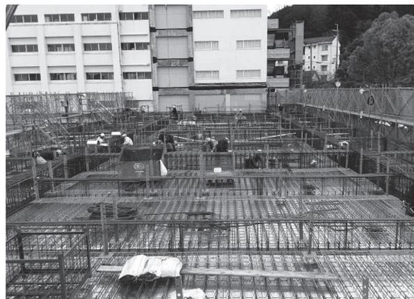
写真 - 5 鉄筋落とし込み工法（落とし込み前）
