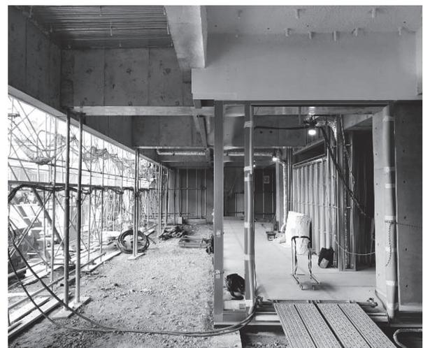
写真 - 2 5.15 m 片持ち梁 (施工時)
