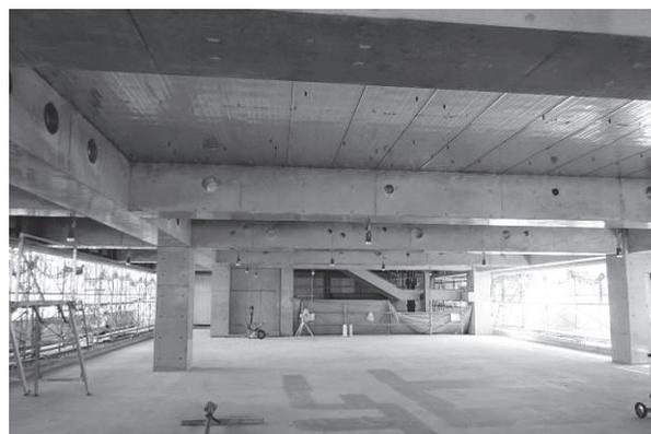
写真 - 6 PRC 梁躯体工事完了
