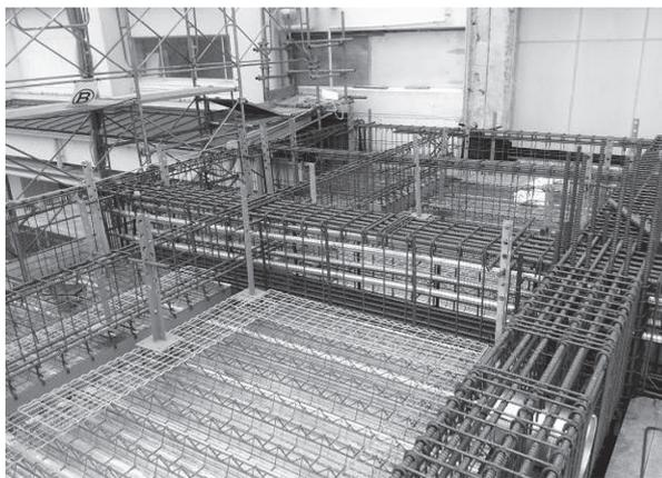
写真 - 4 5.15m 片持ち梁シース管配管状況
