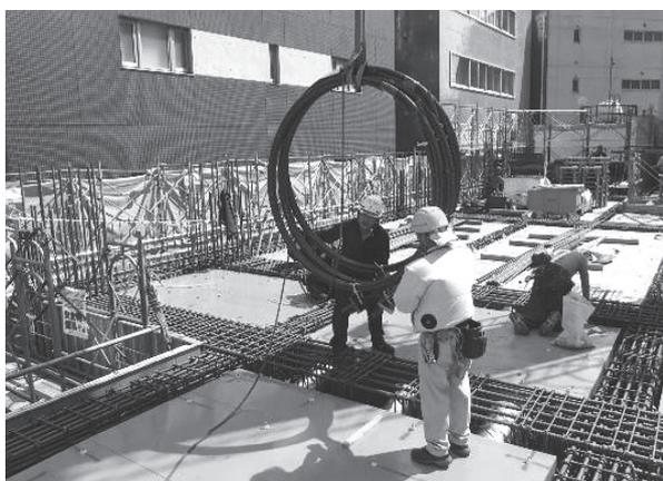
写真-7 PC鋼より線揚重状況
