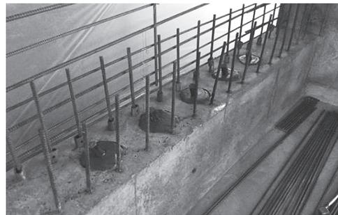
写真 - 12 PC 鋼棒 PC グラウト注入完了
