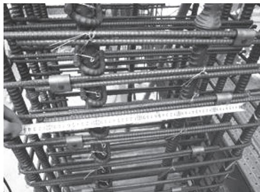
写真 - 5 機械式重ね継手工法によるフープ筋組立て
