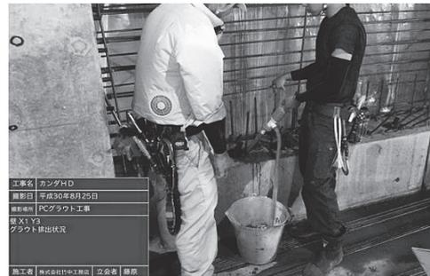
写真 - 11 PC 鋼棒 PC グラウト排出状況
