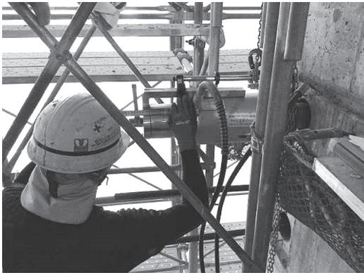
写真 - 8 PC 鋼線ジャッキセット
