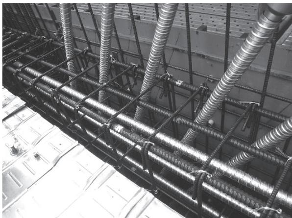
写真-6 PC鋼棒・PC鋼より線交差部シース管施工状況
