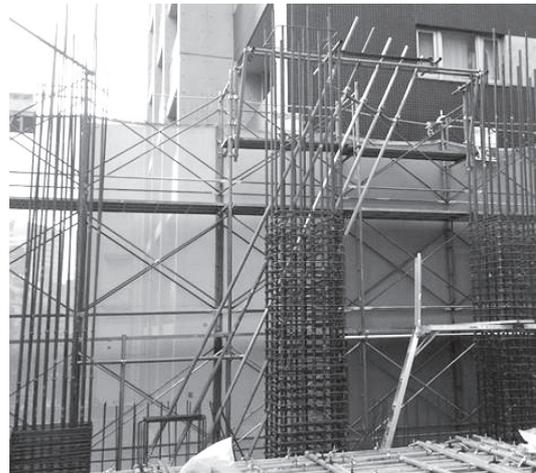
写真 - 3 柱貫通部 PC 鋼棒ダミー単管パイプ設置
