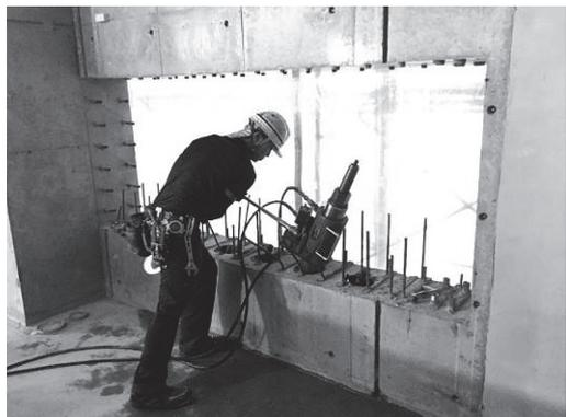
写真 - 9 PC 鋼棒ジャッキセット
